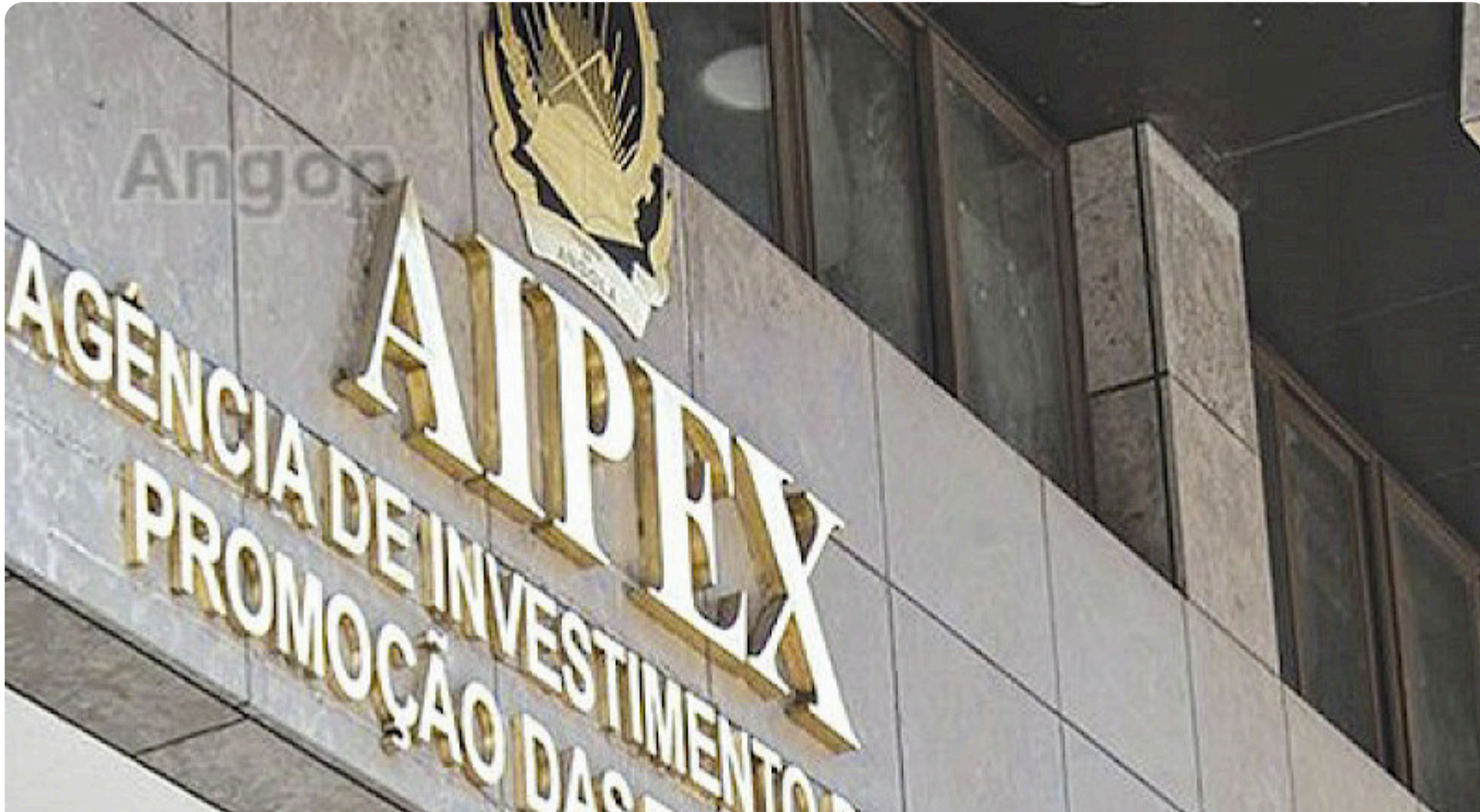
Edifício da AIPEX
