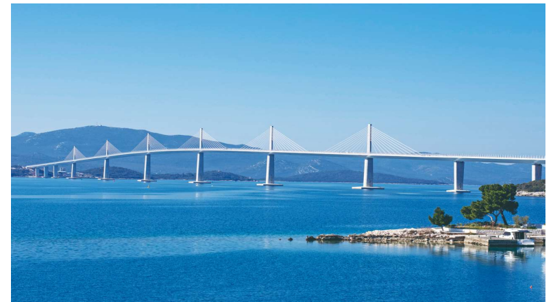
Ponte Marítima de Pelješac, na Croácia
