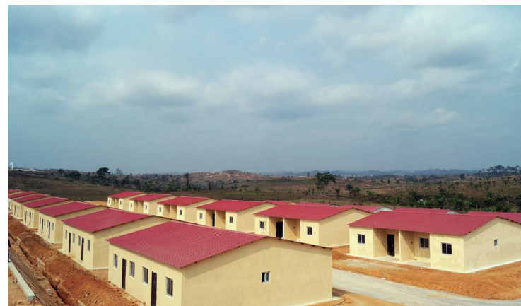
Projeto de Habitações de 500 Casas na Província Uíge (Fase I)
