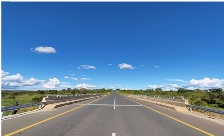
Projecto da Reabilitação da Estrada EN230 Malange X Saurimo- Lot1
