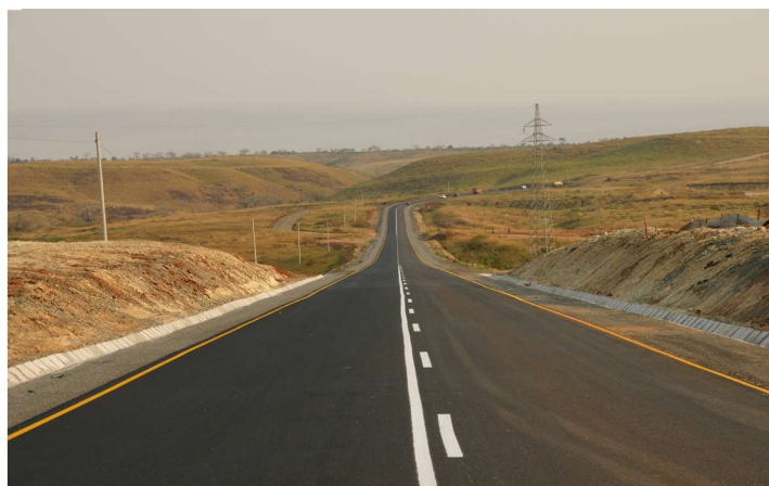
Projecto de Reabilitação da Estrada Kifangondo-Caxito-Uíge-Negage
