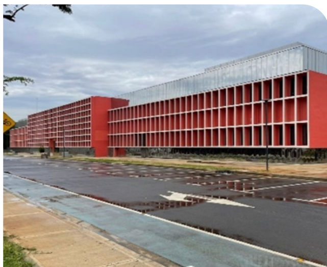
Retrato n.º 1 - Edifício da Direcção Geral
