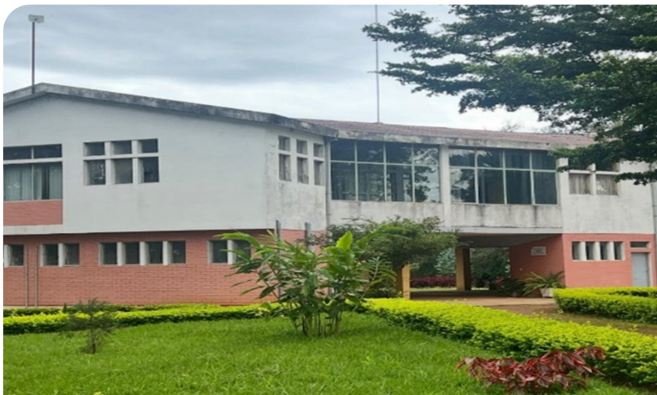
Retrato n.º 1 - Edifício da Direcção Geral
